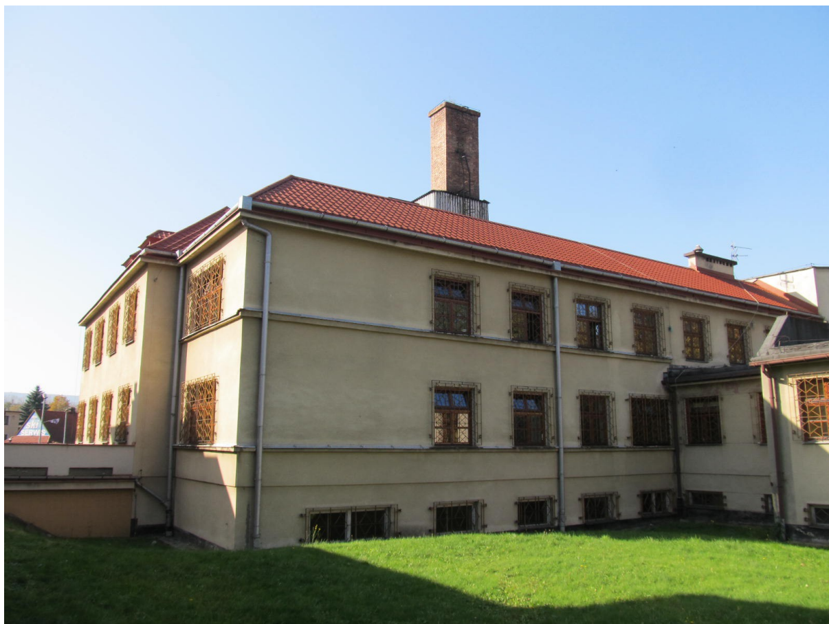
Wojewódzki Szpital Psychiatryczny w Andrychowie – Segment CD – istniejąca elewacja niedocieplona
