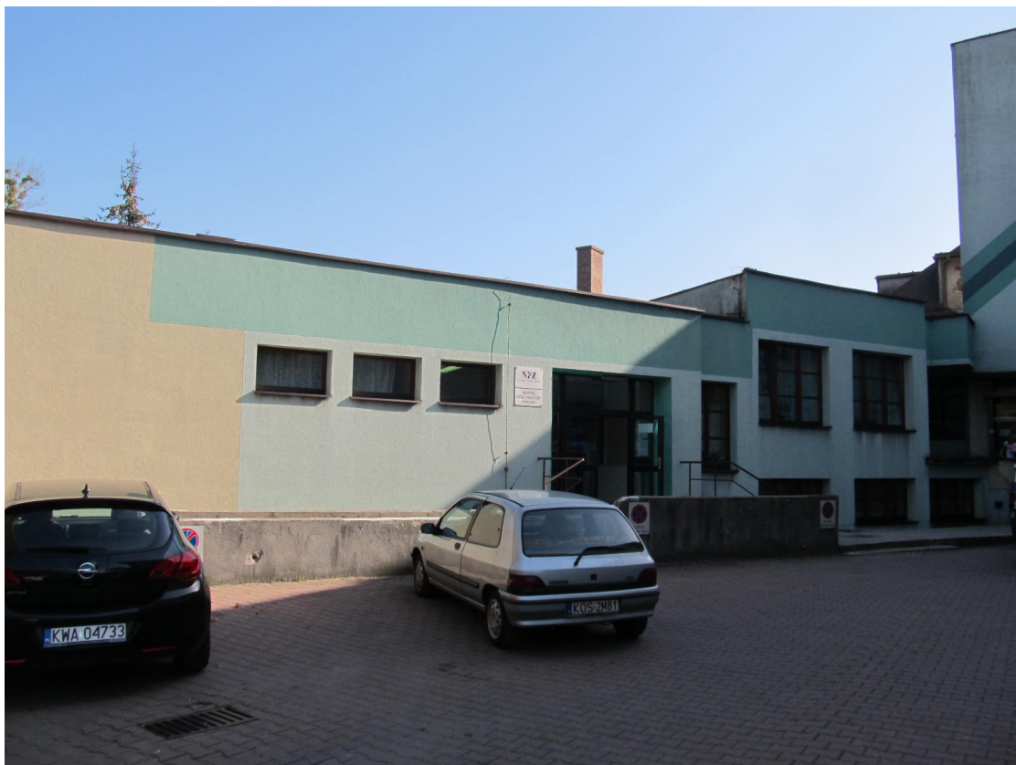
Wojewódzki Szpital Psychiatryczny w Andrychowie – Segment B – istniejąca elewacja docieplona.
