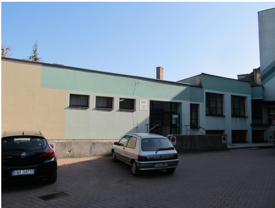
Wojewódzki Szpital Psychiatryczny w Andrychowie – Segment B - widok od strony wejścia głównego
