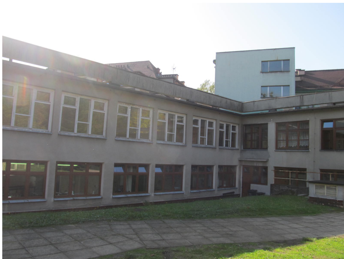
Wojewódzki Szpital Psychiatryczny w Andrychowie – Segment B – istniejąca elewacja niedocieplona
