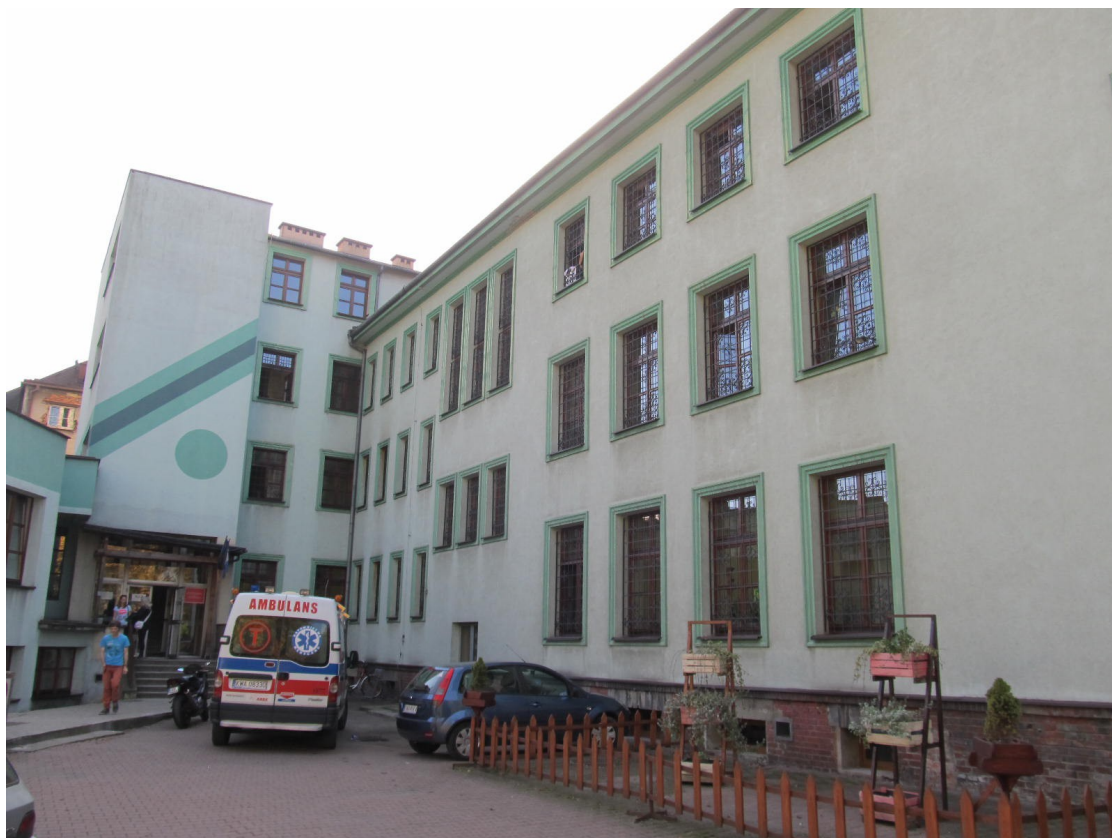
Wojewódzki Szpital Psychiatryczny w Andrychowie – Segment A - widok od strony wejścia głównego
