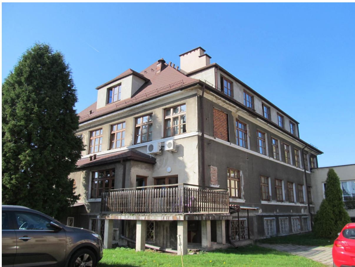
Wojewódzki Szpital Psychiatryczny w Andrychowie – Segment A cz. II – istniejąca elewacja niedocieplona
