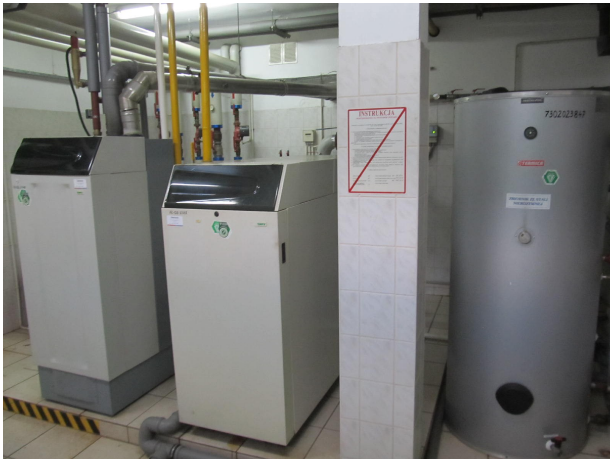
Wojewódzki Szpital Psychiatryczny w Andrychowie – Segment A – istniejąca kotłownia
