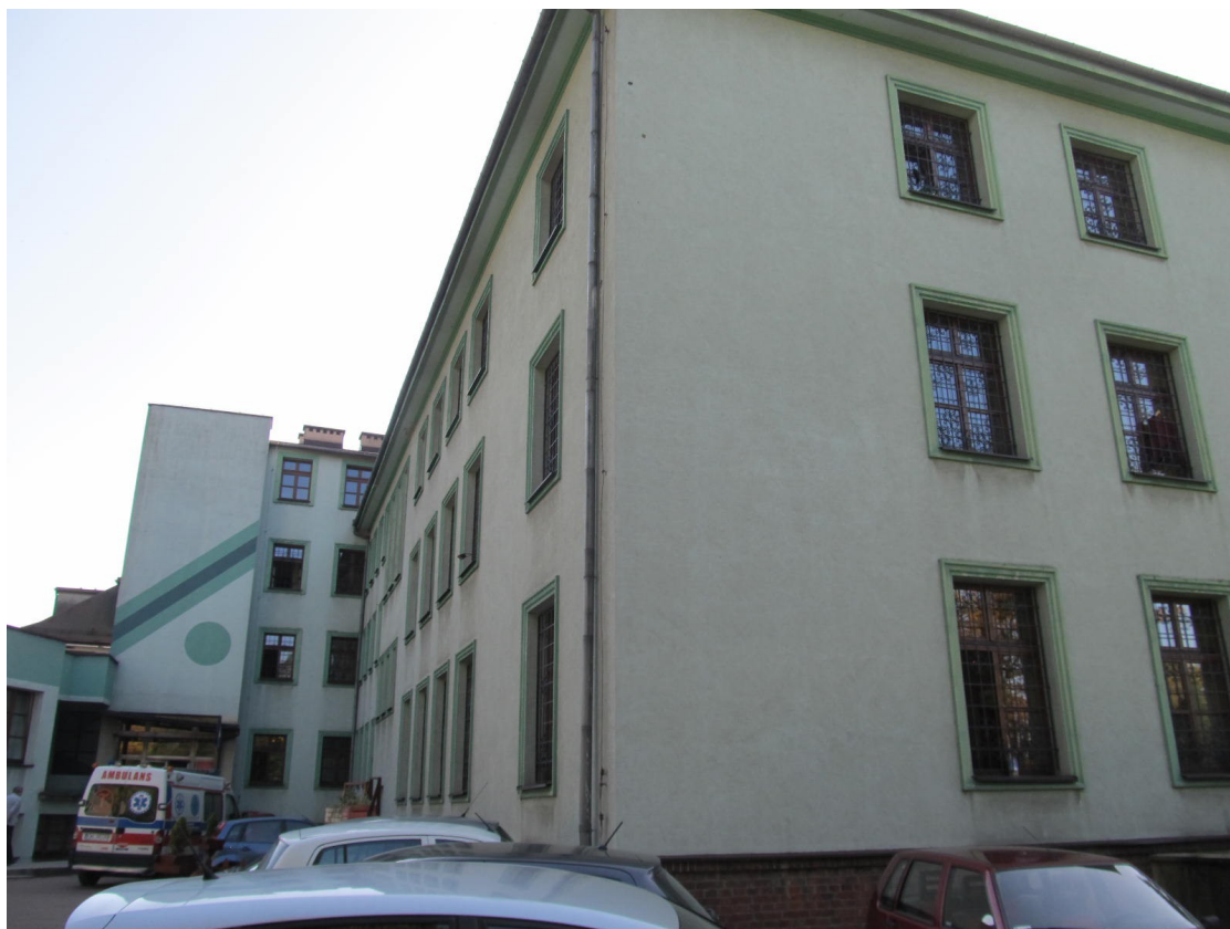
Wojewódzki Szpital Psychiatryczny w Andrychowie – Segment A cz. I – istniejąca elewacja docieplona
