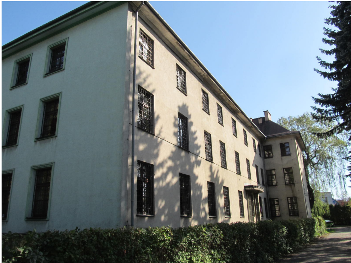
Wojewódzki Szpital Psychiatryczny w Andrychowie – Segment A cz. I – istniejąca elewacja docieplona i niedocieplona
