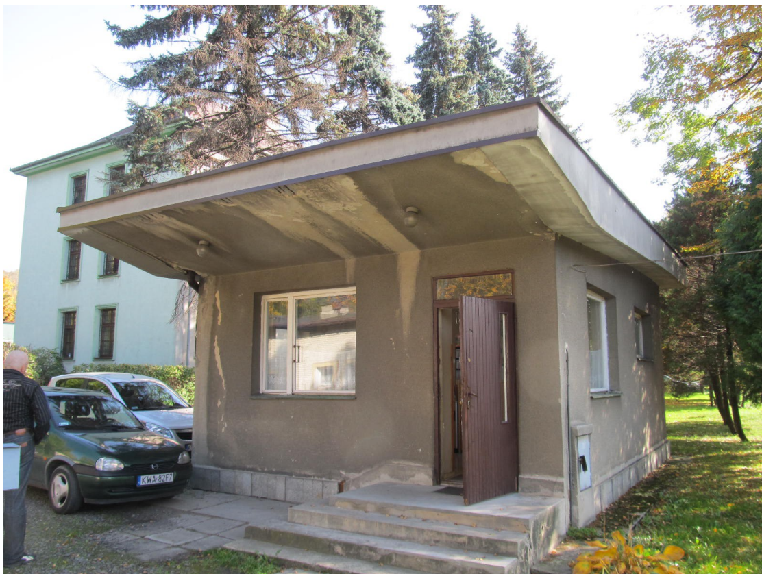
Wojewódzki Szpital Psychiatryczny w Andrychowie – Portiernia - widok od strony wejścia głównego
